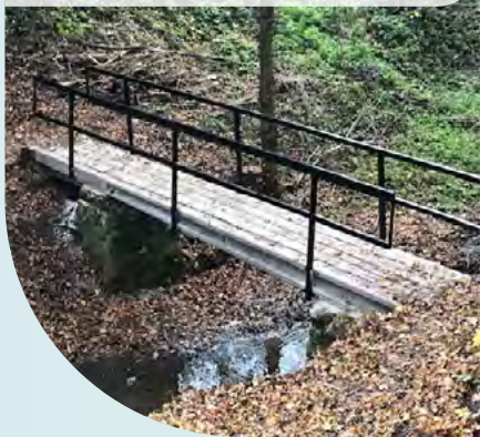
Rénovation du Pont Moulin Royer en partenariat avec Bulhon.
