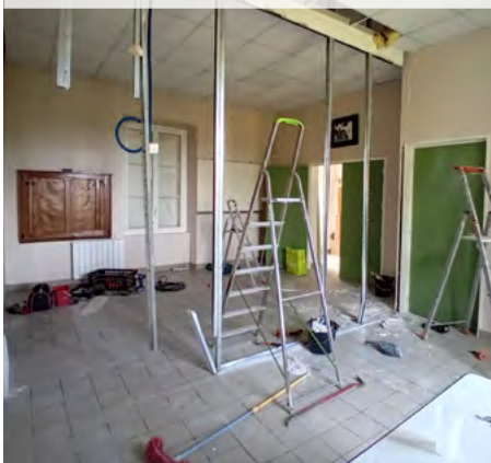
Création salle de réunion Mairie. AVANT / APRÈS
